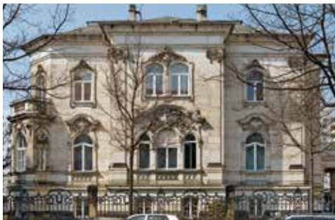
Neobarocke Villa mit überschwänglich dekorierten Fenstern, Hohe Straße 22
