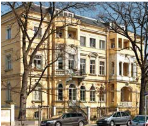
Mietvilla mit unterschiedlich gestalteten Risaliten, Eisenstückstraße 39/ Ecke Rugestraße
