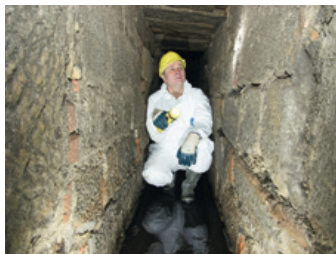
Frank Männig begutachtet Dresdens ältesten Kanal, den die Italiener vor 270 Jahren unter dem Theaterplatz gebaut hatten.
