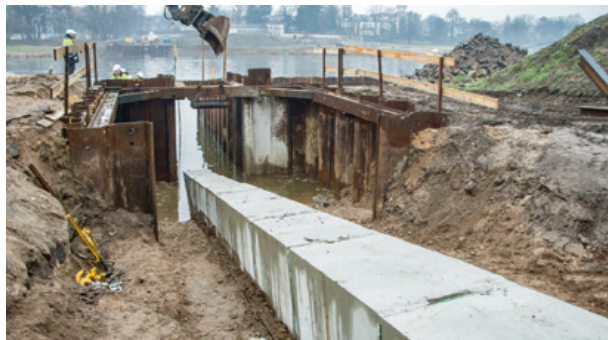
Bei einer Großaktion wird der Abwassertunnel vom Johannstädter Ufer in Richtung Neustadt durch die Elbe gezogen. Ein starker Betonmantel schützt die biegsame Leitung. Damit wird eine neue Abwasser-Verbindung zum Altstädter Abfangkanal geschaffen.
